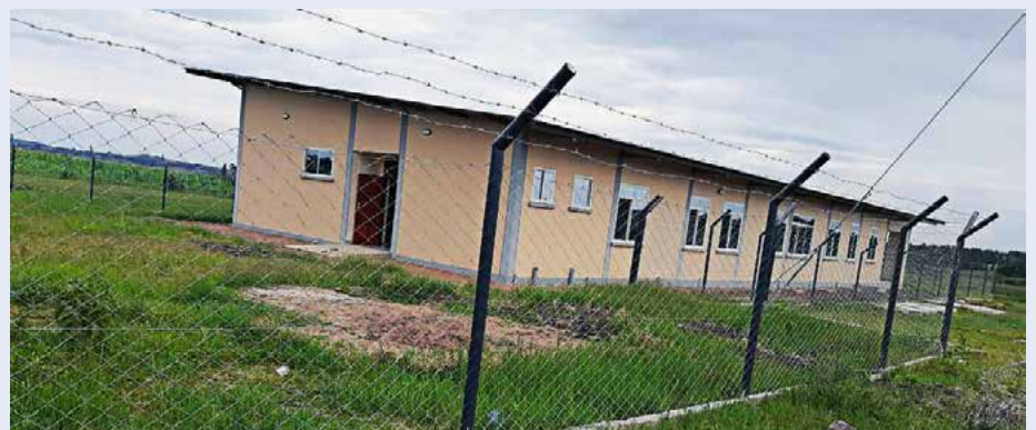
Neue Elektrostation am Gesundheitscenter Kisesa in Tansania
