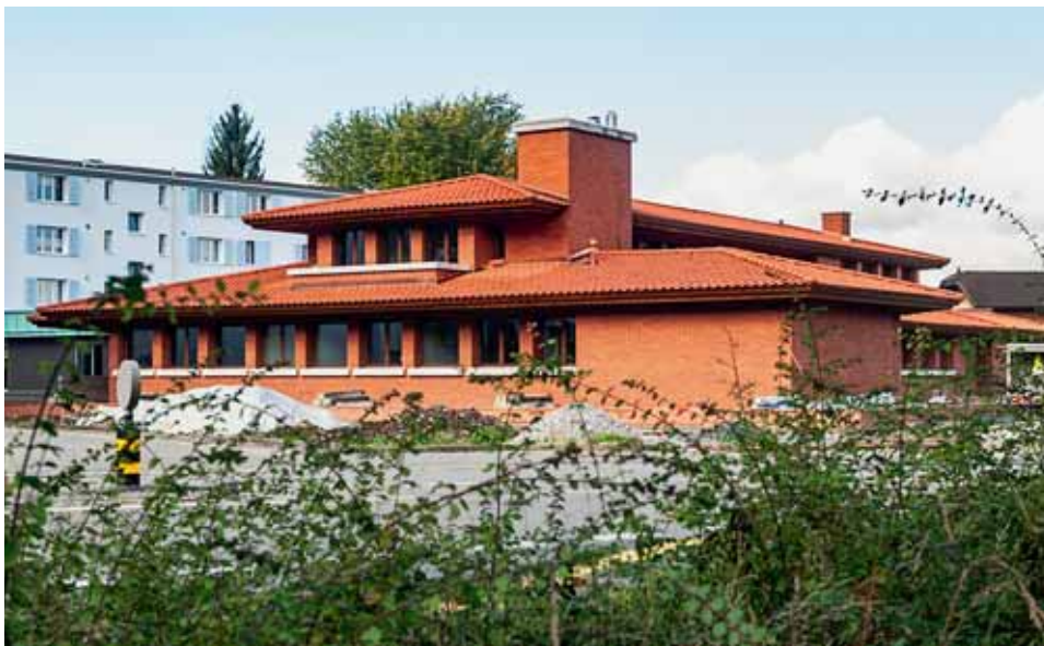
Das Hospiz Zentralschweiz entsteht an der Gasshofstrasse 18 in Littau/Luzern.
