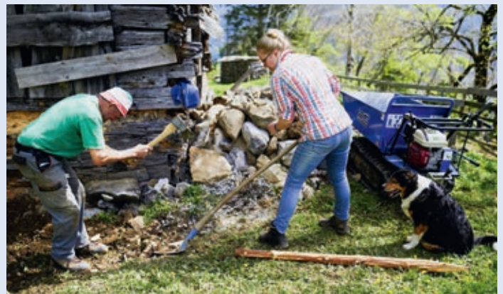
Eine Freiwillige hilft, den verwitterten Weidestall für die Rinder zu reparieren.
